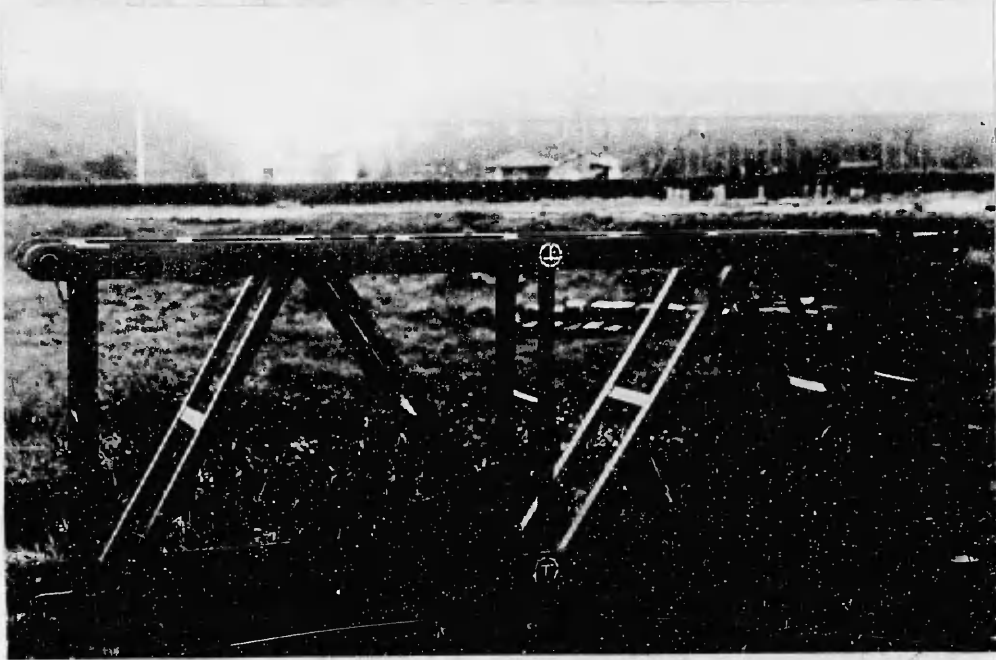
輕構桁部分桁
