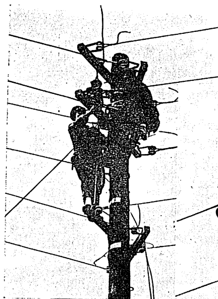
壓縮機に依る ジャンパージョイントの柱上作業
